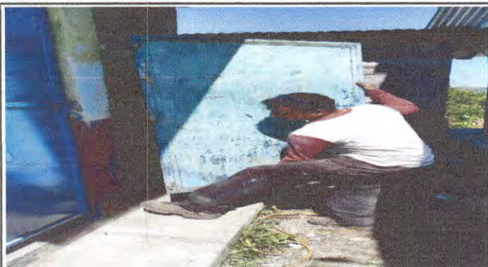
Foto1: Mantenimiento a estructura puertas (lijado, cambio de tubo , cepillado, sujeciones, aplicación de pintura), modulo de baños.
