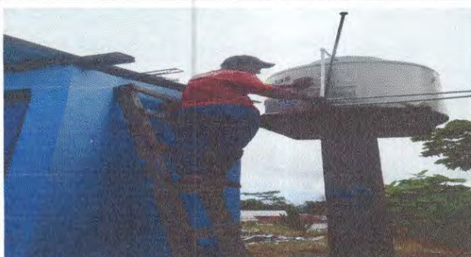
Foto 4: Sustitución de deposito de agua 1100 lt
