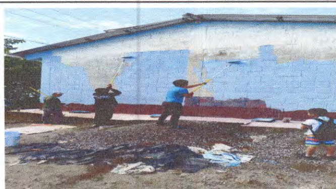
Foto 2: Pintura en muros exteriores e interiores, modulo de aula.
