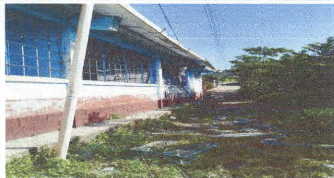
Foto 5: Sustitución de canal de metal Y Sustitución de bajada de agua pluvial de metal por tubo PVC 3"
